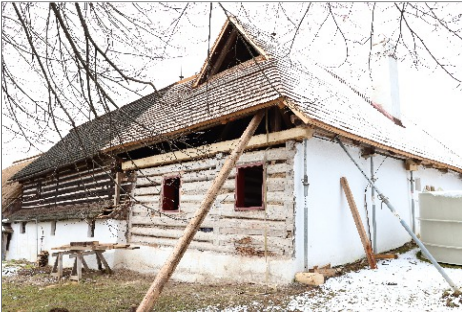
Oprava objektu usedlosti u Pilných čp. 4 na Veselém Kopci
