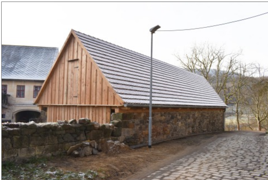
Rekonstrukce kolny na vozy v čp. 27
