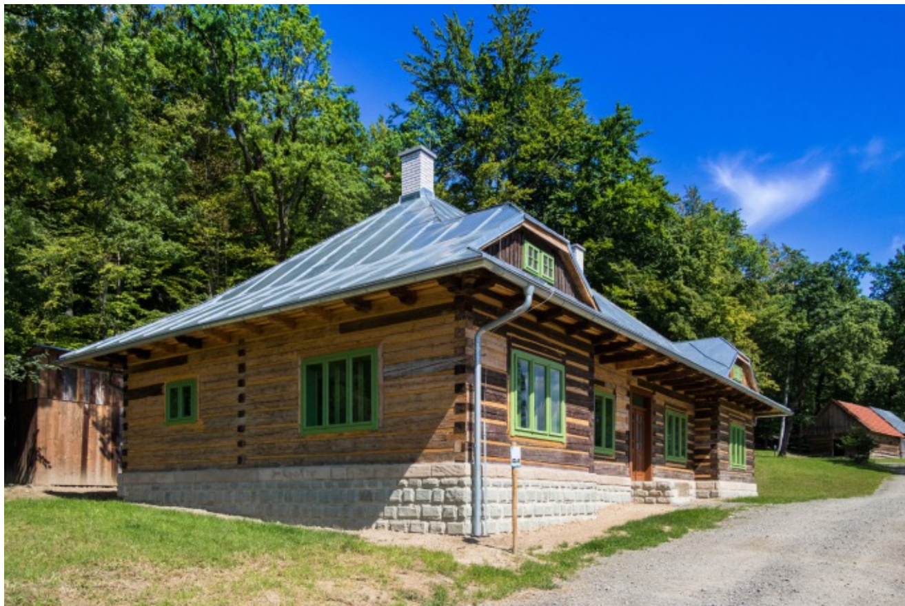
► Nový objekt hájovny přenesený z Valašské Bystřice
