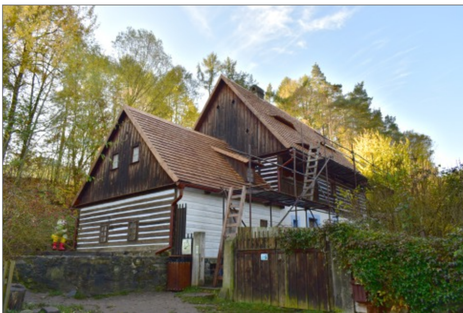
Oprava střechy mlýna Týniště čp. 27
