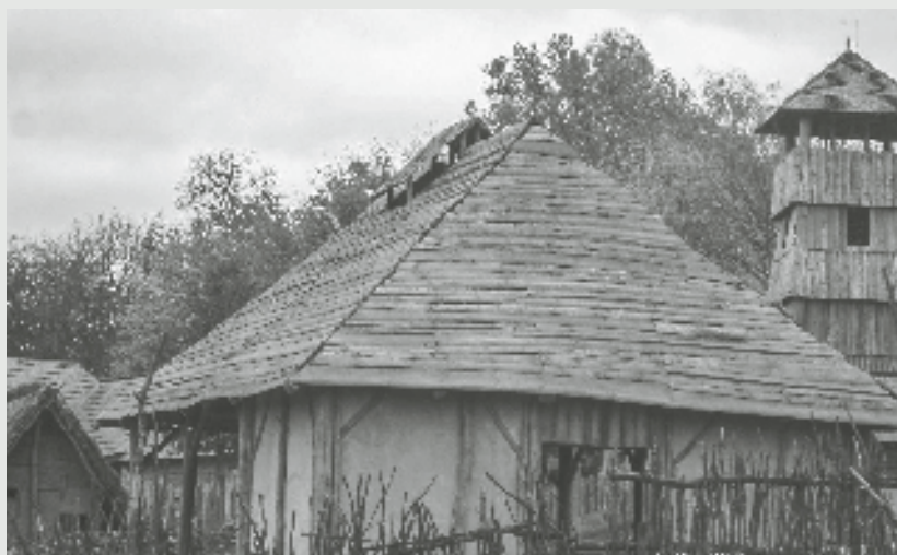
Odvod kouře v rekonstrukci středověkého objektu v Archeoskanzenu Modrá. Foto: Antonín Šimáček, 2012
