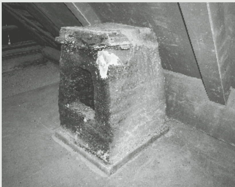
Jedním z kompromisů, které Valašské muzeum v přírodě přijalo při rekonstrukci funkčního topeniště v chalupě z Lužné, bylo užití desek CETRIS® na obložení okolí vývodu dymníku v podstřeší. Foto: Jan Kolář, 2014. Z fotoarchivu Národního muzea v přírodě
