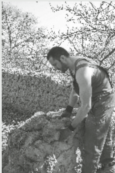
Řízená demolice stěny postavené z hliněných válků ve tvaru rovnostranného trojúhelníka, Tištin (okres Prostějov) čp. 13. Foto: Martin Novotný, 2011. Z archivu NÚLK
