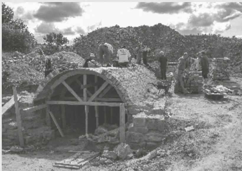
Výstavba sklepa expozičního objektu z obce Tučapy. Foto: Jan Blahůšek, 2015. Z archivu parku Rochus, o. p. s
