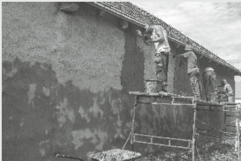
Omítání hliněných stěn hliněnou omítkou v MVJVM. Foto: Martin Novotný, 2016. Z archivu NÚLK
